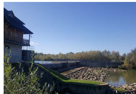
Jaz z Małą Elektrownią Wodną na Wisłocy w Mokrzczu
