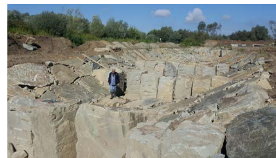
Dolny fragment przepławki – widok na jeden z basenów spoczynkowych
